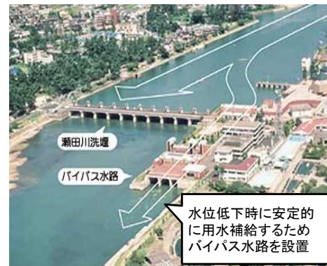
瀬田川洗堰の改築
