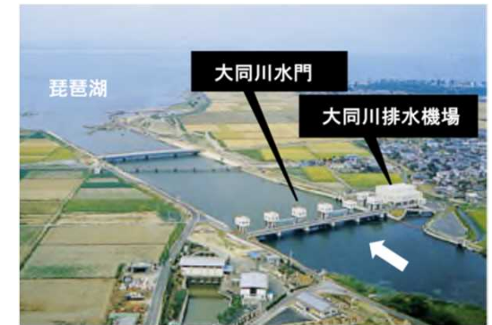
内水排除施設(14箇所)
