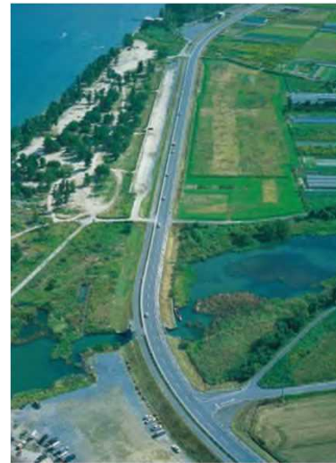
湖岸堤・管理用道路の建設(50.4km)
