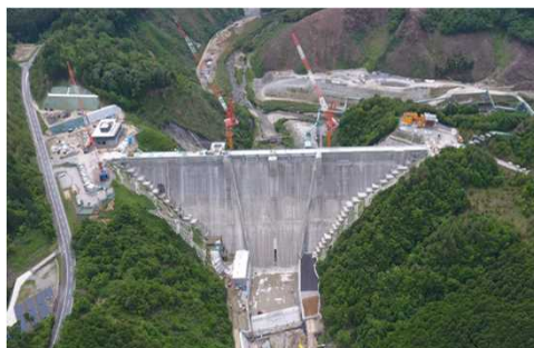
ダム本体の施工状況 （ダム下流側より令和3年（2021年）5月撮影）
