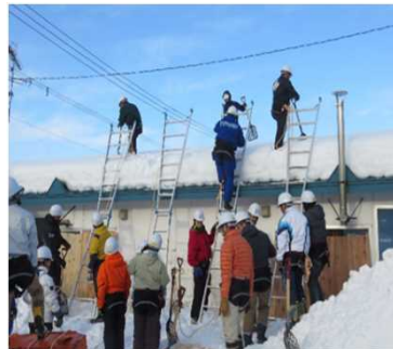
雪下ろし実技講習
