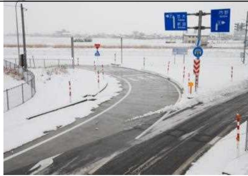
<インターチェンジランプ部の融雪施設>
