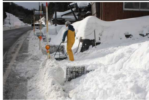
<流雪溝を利用した除雪作業>
