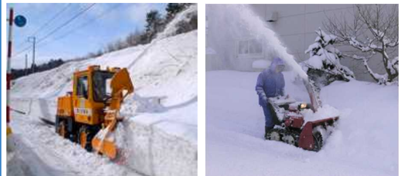
小型除雪車 (左) や小型除雪機 (右) を使用した道路の除雪
