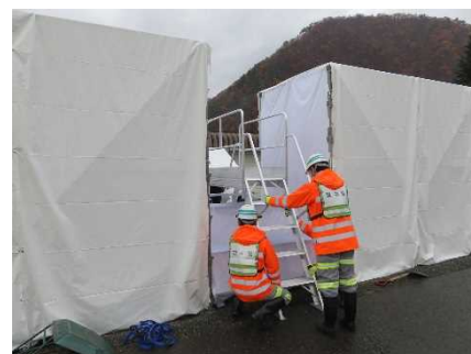
<中央分離帯に仮設のデッキプレート設置訓練>
