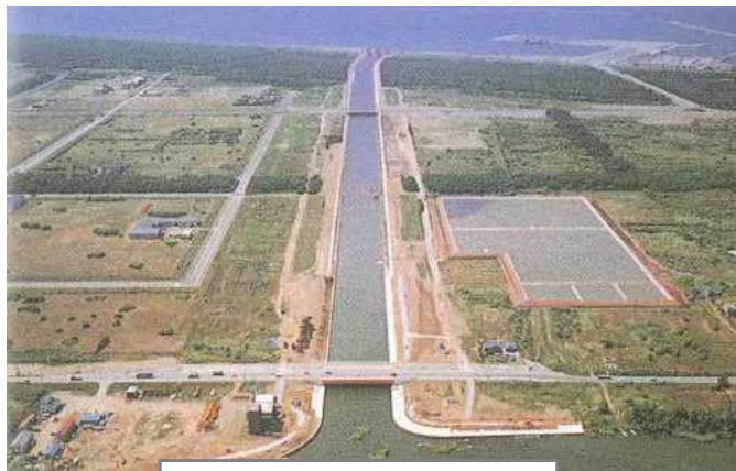
石狩放水水路完成(S57)
