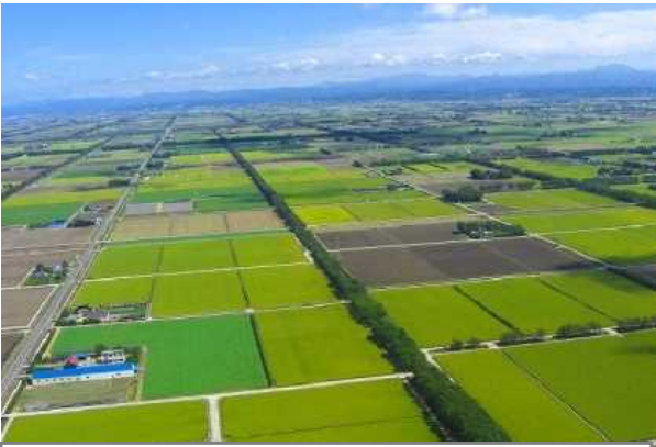
国営農地再編整備事業「中樹林地区」工事着工(H12)
