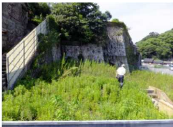
雑草が繁茂している土地
