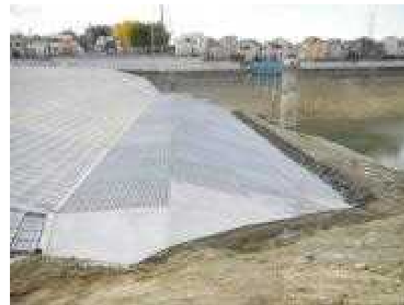
耐震補強対策（押え盛土工）
