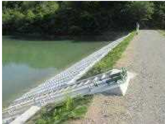
老朽ため池の改修
