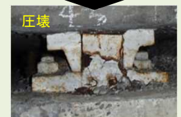
ファイバースコープを挿入し、支承内部の腐食・固着・圧壊を発見 → 橋梁端部の構造を改良する必要
