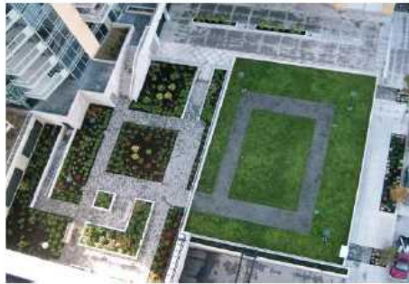
高層ビルの屋上緑化 雨水管理だけでなく、屋根を保護する効果なども期待されている。
