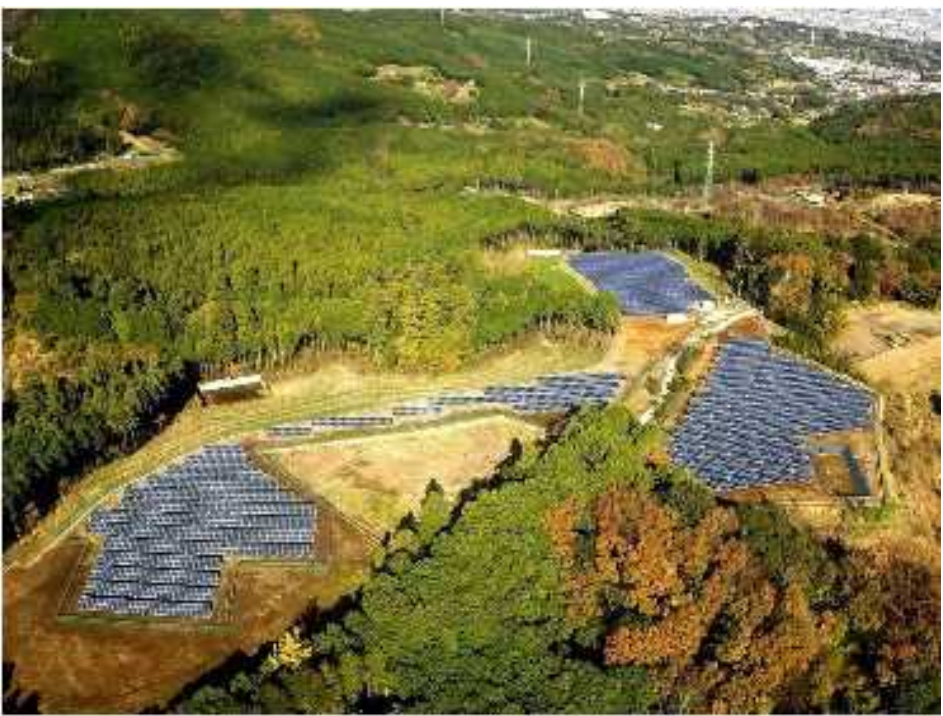
太陽光発電設備
