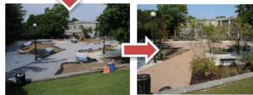
下水道エリア内の私有地を緑化し、雨水管理に貢献することに対して助成金が支払われる
