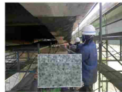
修繕の様子(断面修復)
