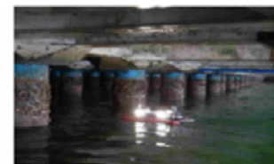
ROVによる撮影状況
