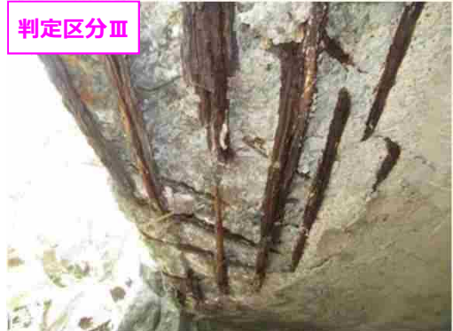
床版鉄筋露出 ※床版:橋の裏側
