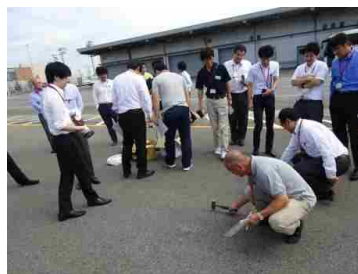
打音調査の実施状況
