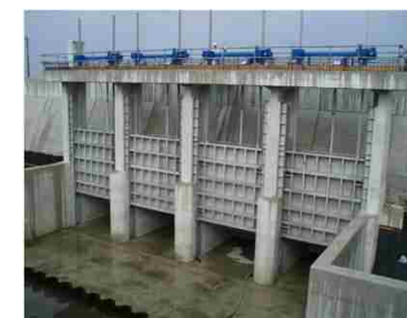
海岸保全施設(水門)
