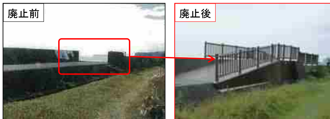
スロープを設置し陸閘を廃止
