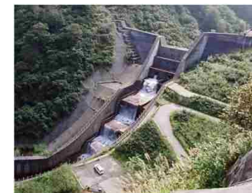
砂防施設(砂防堰堤)
