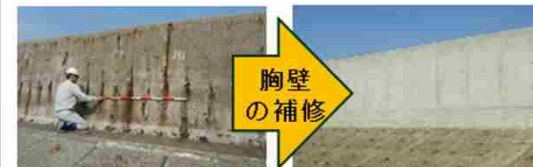
コンクリート劣化・鉄筋露出
