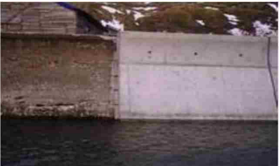
老朽化対策による改良例
