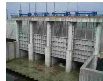
海岸保全施設(水門)
