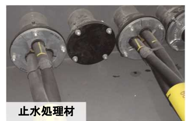
脱着型止水板
