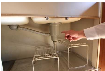
水道管の確認
