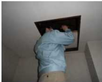
「小屋組・梁」調査の様子
