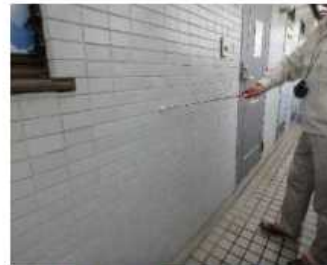
「外部（外壁）」調査の様子
