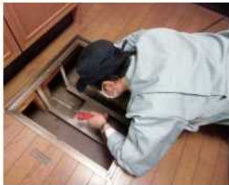
「土台・床組、基礎」調査の様子
