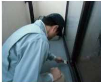
「外部（バルコニー）」調査の様子
