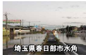
写真2: 令和元年東日本台風の国道4号の冠水
