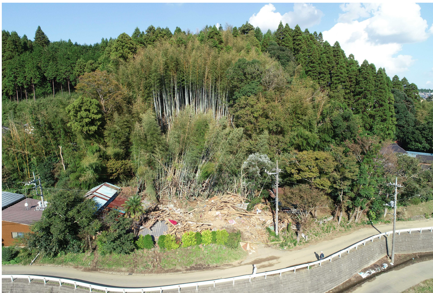
千葉県千葉市緑区板倉町 いたくらちょう で発生した土砂災害
