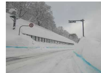
青い塗料(ブルーライン)の塗布 (山形河川国道事務所管内)
