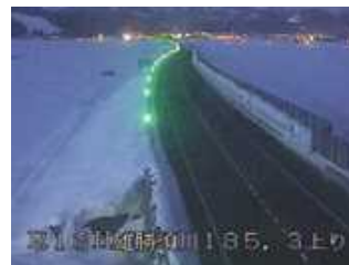
自発光式LED視線誘導標 (湯沢河川国道事務所管内)
