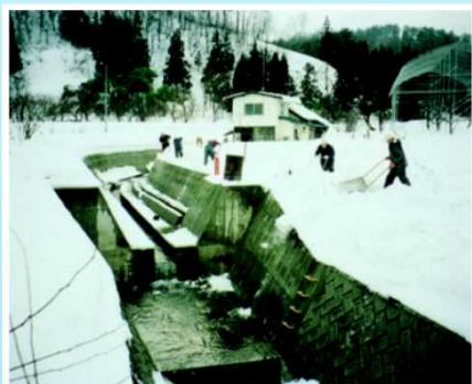
除排雪低水路（山形県村山市）
