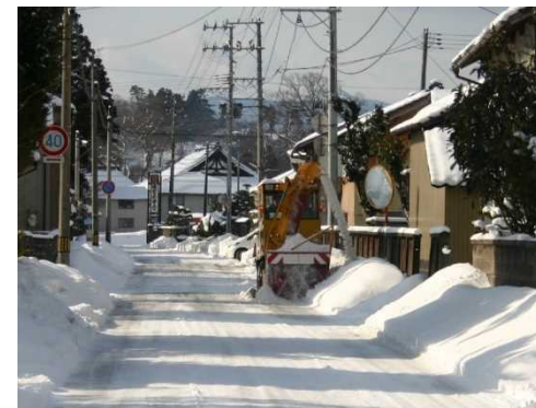
▲鶴岡市内の支援機械による除雪作業の様子
