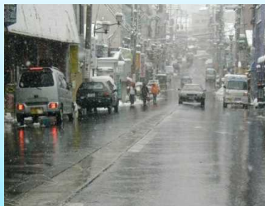
下水処理水を活用した消雪
