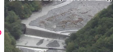
台風第19号 砂防堰堤が土砂・流木を捕捉(小瀬戸第1砂防堰堤(三峰川本川上流部))
