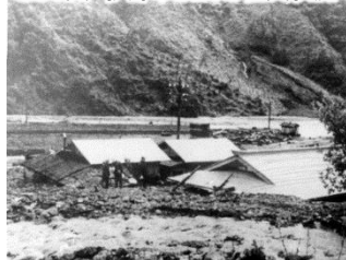
S36災 伊那市長谷の被災状況
