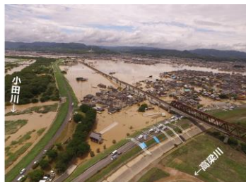
⑥小田川における浸水被害 (岡山県倉敷市)
