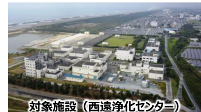
対象施設（西遠浄化センター）
