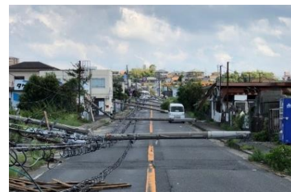
【H30 台風第21号 電柱倒壊状況（大阪府泉南市）】
