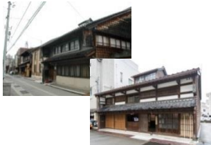
まちなかでの空き町家の修繕等への補助
