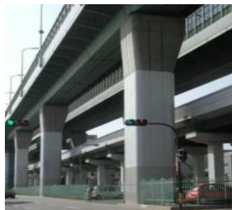
阪神高速道路の橋脚
