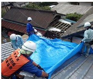
ブルーシートの設置状況（千葉県山武郡芝山町）
