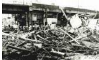
昭和42年災害の被災状況
