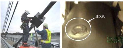
(例) 自走式ロボで斜材表面を撮影
