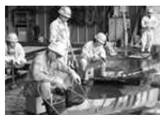
ぎょう鉄(鉄板曲げ加工)
