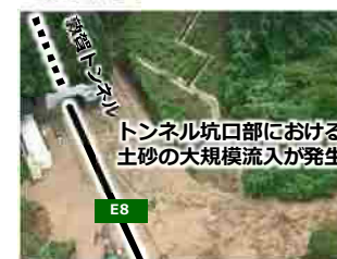
土砂の大規模流入 E8北陸自動車道 令和4年8月の大雨
