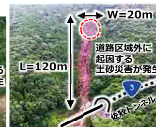
道路区域外の斜面山頂部からの 大規模崩落 国道3号 令和2年7月豪雨
