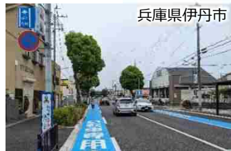
兵庫県伊丹市 自転車専用通行帯の整備
