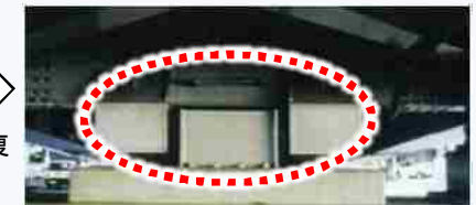
支承への負荷軽減の為、支承の間に、水平力を分担する構造を新たに設置
