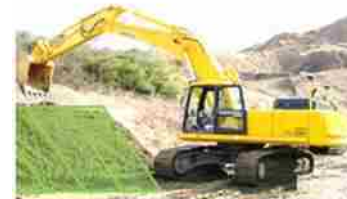
ICT施工の活用
