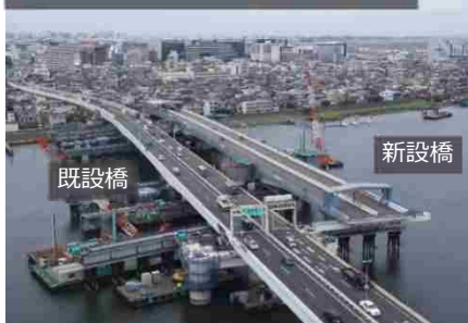
①新設橋設置前（撮影日：R5.5.26）
