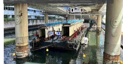
現在の工事状況（呉服橋出入口撤去） （撮影日：R5.4.19）
