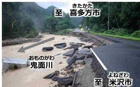
国道121号 令和4年8月の大雨
