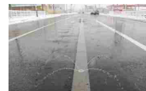
消融雪施設等の整備
