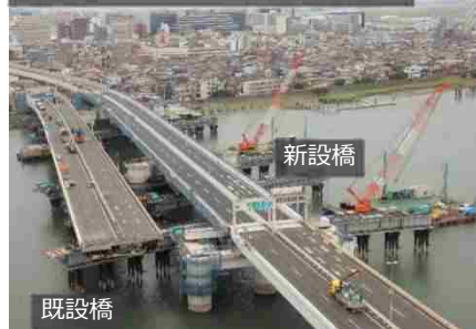
②新設橋設置後（撮影日：R5.6.8）
