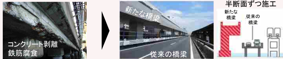
構造物全体の架け替えを実施
