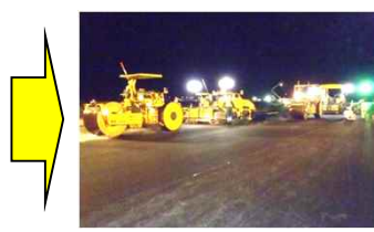
(老朽化した滑走路舗装の改良)
