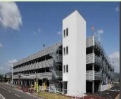
立体駐車場建設 収容台数:1003台 ⇒1393台
