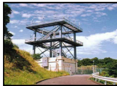
遠隔対空通信施設
