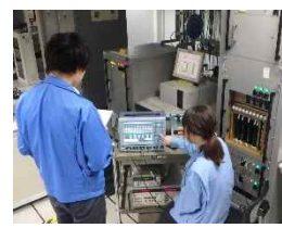
(航空保安施設点検実施状況)
