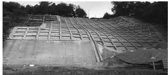
コンクリート枠による斜面の補強
