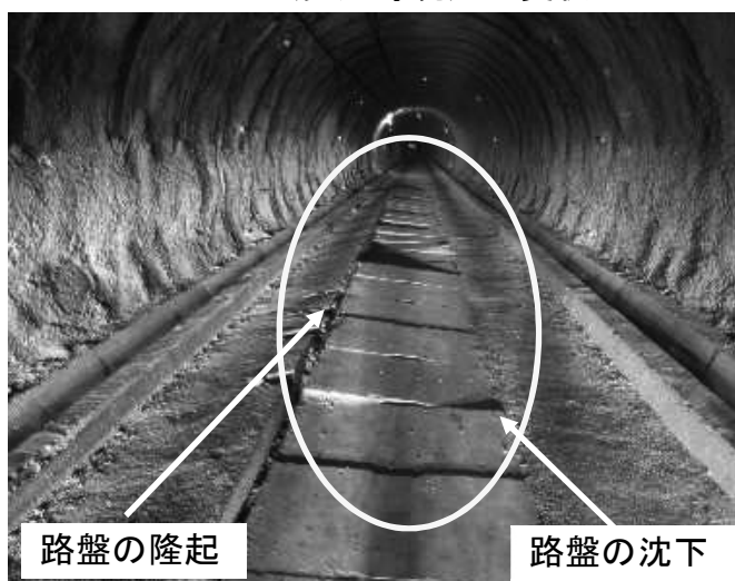
トンネル（先進導坑）の変状
