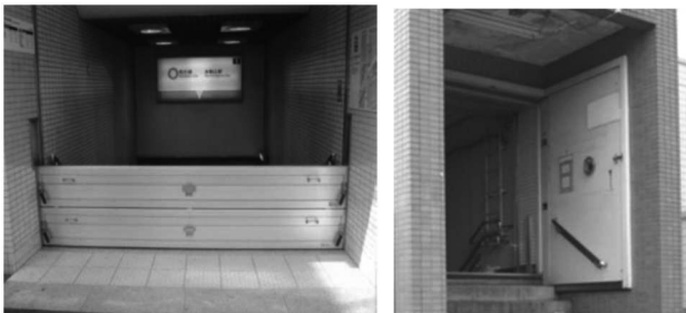
止水板・防水扉の整備
