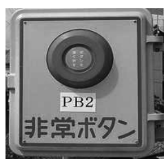
非常押しボタン
