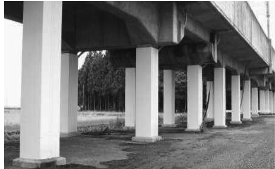
鋼板巻きによる高架橋の耐震対策
