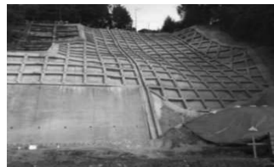
斜面の補強
