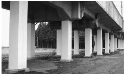
鋼板巻きによる高架橋の耐震対策
