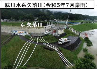
排水作業で堤防天端を使用すると復旧活動で堤防上を往来できない
