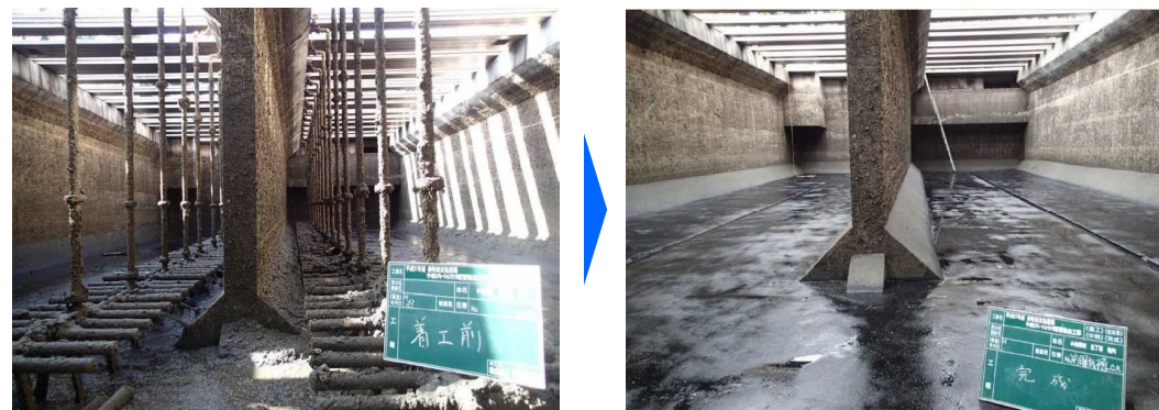
調整池への改造の例（反応タンク内の散気装置撤去）
