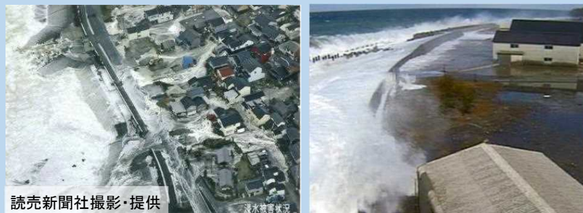
高波による越波・浸水状況
