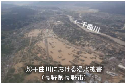
【令和元年東日本台風】
