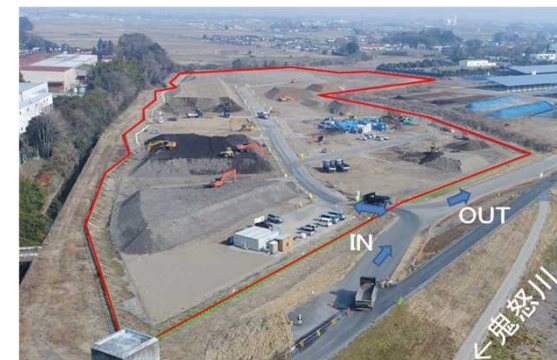
鬼怒川で使用していたストックヤード
