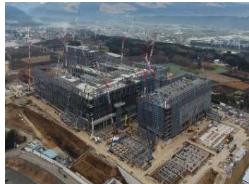
イメージ (建設中の半導体工場)
