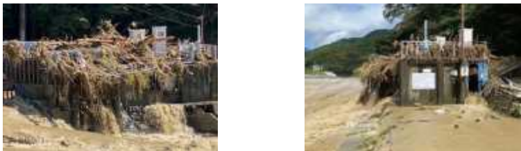
写真 興津川承元寺取水口の被災状況（静岡県静岡市）
