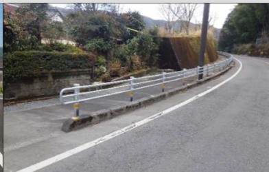
防護柵の設置
