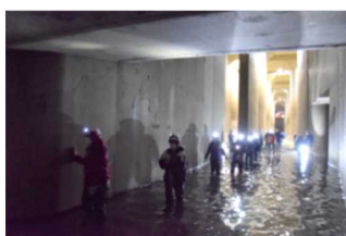
内部見学ツアー（首都圏外郭放水路）
