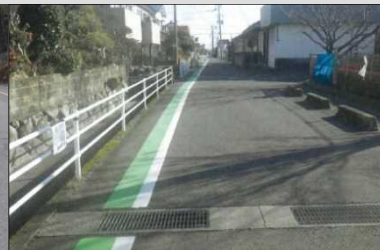
区画線の設置・カラー舗装
