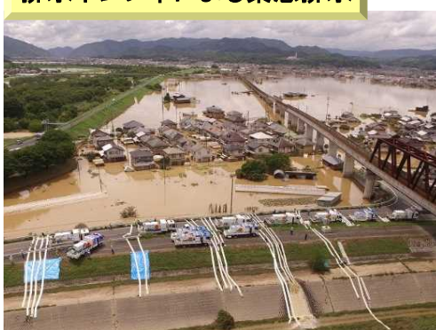
【平成30年7月豪雨】 (岡山県倉敷市真備町)
