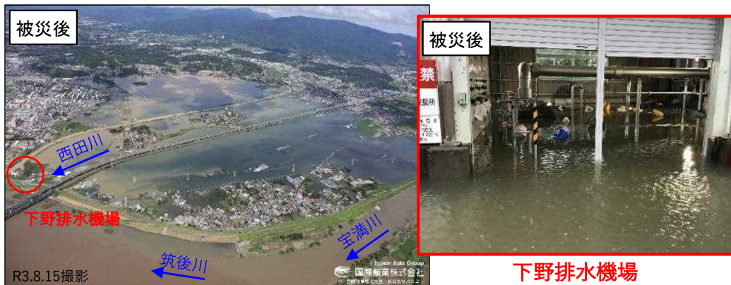
令和3年8月の大雨による被害（佐賀県西田川）
