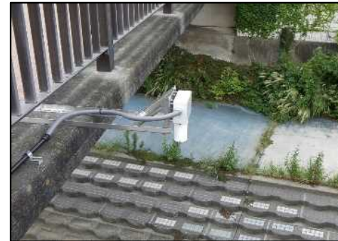
水位計の整備、改良
