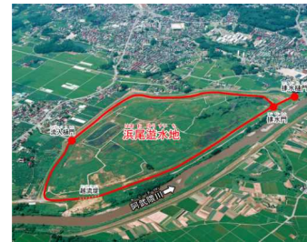
浜尾遊水地(既設)
