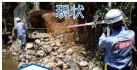
現状 ボール・巻尺などによる計測、野帳スケッチ、被災箇所撮影
