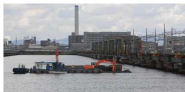
橋梁架替工事における船舶の利用
