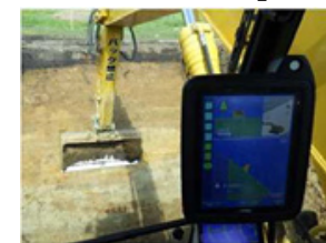
道路の新設工事におけるICT建設機械での切土面の掘削状況
