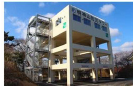
津波避難タワーの整備 (積雪寒冷を考慮した防寒機能付)
