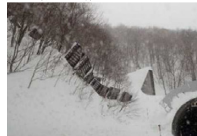
道路斜面における雪崩予防柵設置例
