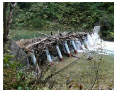
〈流木捕捉機能を持った治山ダム〉
