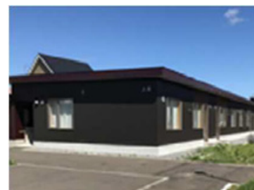
道産材を活用した道営住宅(余市町)
