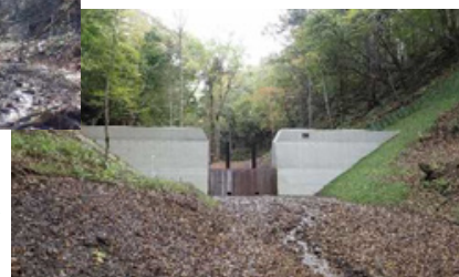
治山ダム設置、危険木除去等による対策 〈土砂流出を抑制し山地災害を防ぐ治山ダム〉
