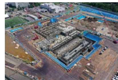
札幌市 新駒岡清掃工場 施工状況 （R6年度完成予定） 資料提供：札幌市
