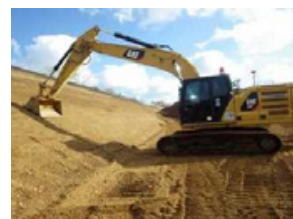
道路の新設工事におけるICT建設機械での切土面の掘削状況
