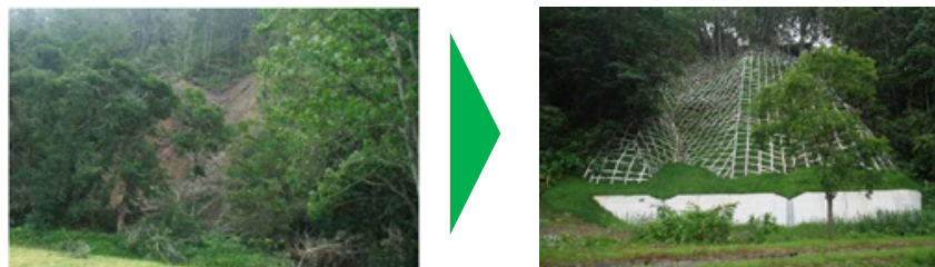
〈斜面の安定を図る山腹工〉
