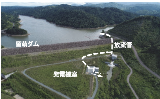
未利用の河川維持放流水を活用した小水力発電の例（留萌ダム（留萌市））
