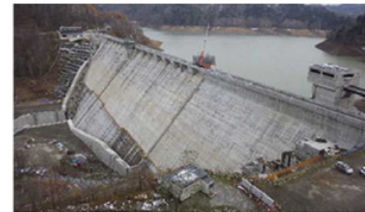
工事中の新桂沢ダム (三笠市)
