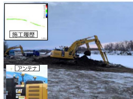
施工履歴を用いたICT施工
