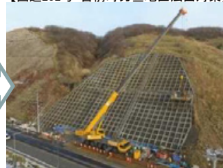
【国道232号 苫前町力屋地区法面対策】
