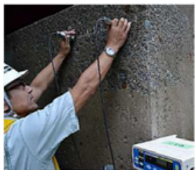
非破壊試験(表面走査法)による凍害点検
