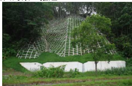
斜面の安定を図る山腹工
