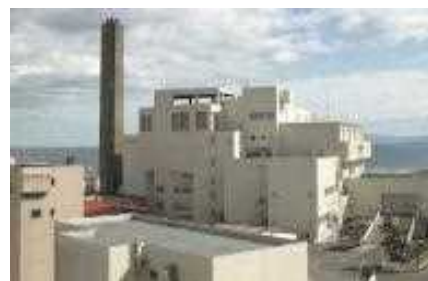
函館市 清掃工場（設備更新工事） （R10年度完成予定） 資料提供：函館市
