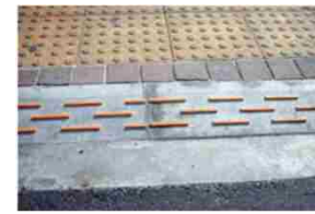
〔視覚障害者、車椅子使用者等に配慮した横断歩道縁端〕
