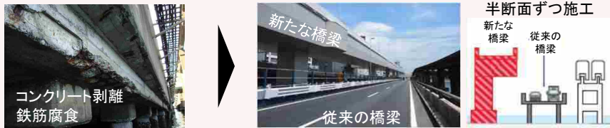
構造物全体の架け替えを実施
