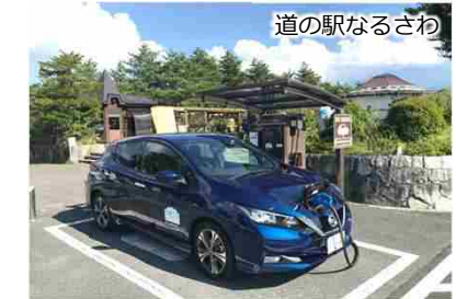
道の駅でのEV充電施設の設置
