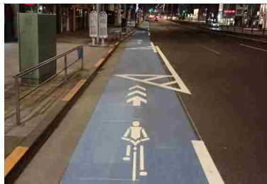
(国道246号:青山地区)
