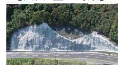
法面吹付工、落石防止網工
