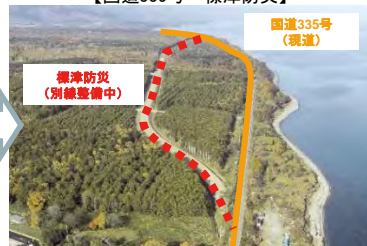
【国道335号 標津防災】
