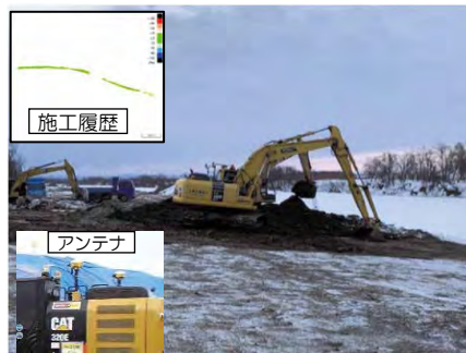
施工履歴を用いたICT施工
