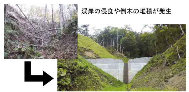
治山ダム設置、危険木除去等による対策 土砂流出を抑制し山地災害を防ぐ治山ダム
