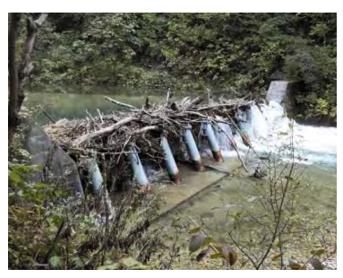
流木捕捉機能を持った治山ダム
