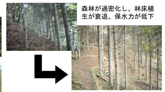
本数調整や工作物設置により 土壌保持、植生回復促進 保安林整備
