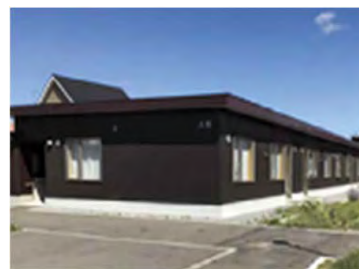
道産材を活用した道営住宅(余市町)
