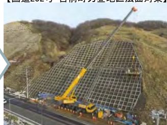
【国道232号 苫前町力屋地区法面对策】
