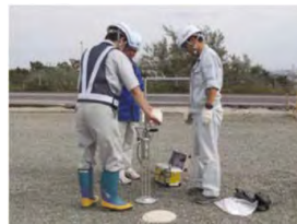
衝撃加速度による盛土の品質管理方法
