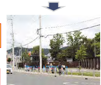
交通安全対策：防護柵
