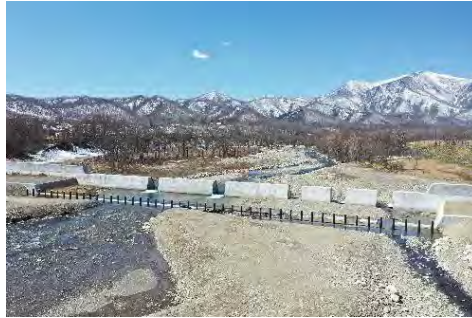
とったべつ 十勝川水系戸蔭別川第2号砂防堰堤（帯広市）
