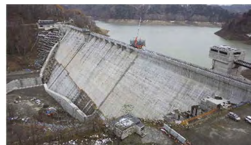
工事中の新桂沢ダム（三笠市）
