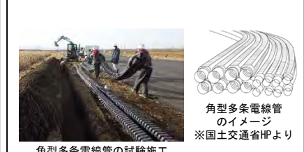
角型多条電線管の試験施工 (寒地土木研究所 苫小牧寒地試験道路)
