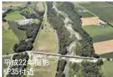
平成22年撮影 KP35付近 礫河原が僅かとなった札幌川
