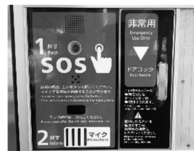
非常通報装置と非常用ドアロックを一体的に案内している例
