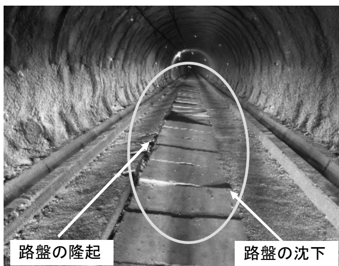
トンネル（先進導坑）の変状
