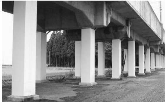
鋼板巻きによる高架橋の耐震補強
