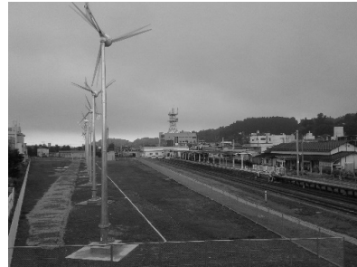
鉄道駅構内における風力発電
