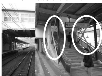
鉄骨ブレースによる 駅ホームの屋根の耐震補強
