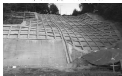
斜面の補強
