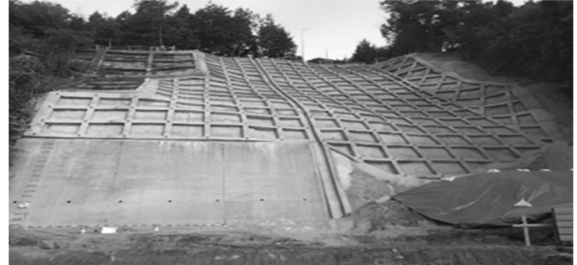
コンクリート枠による斜面の補強
