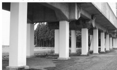
鋼板巻きによる 高架橋の耐震補強
