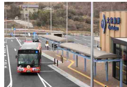
<道の駅大谷海岸に整備された乗換拠点> 気仙沼線 BRT大谷海岸駅 (宮城県)
