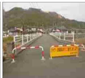
機能縮小により車道を人道橋としてリニューアル 車両は60m先の橋梁を利用
