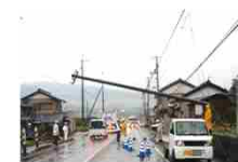
沿道の電柱の倒壊による道路閉塞
