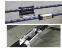
センサーを利用した 橋梁ケーブル張力の モニタリング
