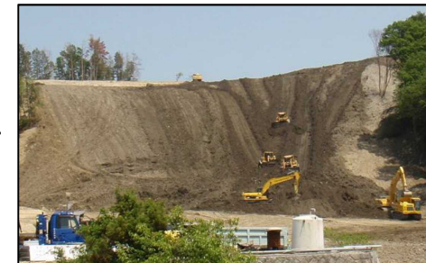
盛土の撤去工事のイメージ
