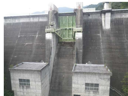
放流設備の改修(塗装、水密ゴム交換)
