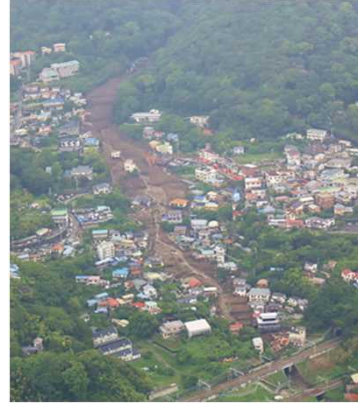
静岡県熱海市における災害発生状況
