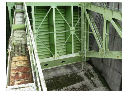
放流設備の改修(塗装、水密ゴム交換)
