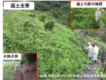
盛土総点検実施状況
