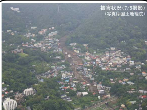
静岡県熱海市伊豆山で発生した 土石流災害
