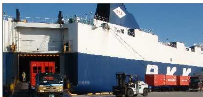
離島のフェリー航路のためのふ頭の整備
