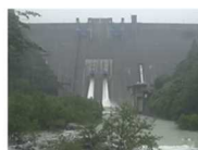
大町ダム事前放流の様子(国交省管理多目的ダム(長野県)信濃川水系高瀬川)
