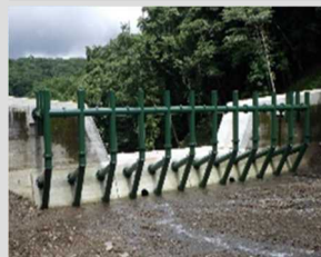
流木捕捉工の追加設置(多機能化)
