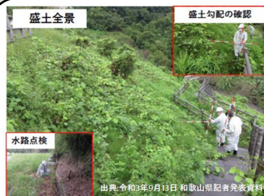
盛土による災害防止に向けた 総点検の実施状況
