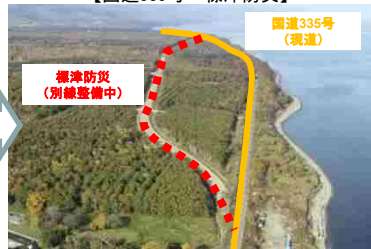
【国道335号 標津防災】
