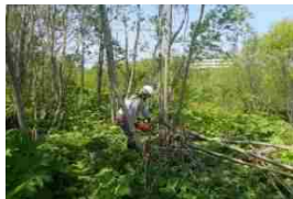
河川管理者による伐採・切断・仮置き
