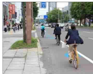
自転車の通行位置を示す矢羽根型路面表示の設置例 一般国道230号(札幌市)
