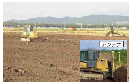
濃霧条件下でのICT施工状況
