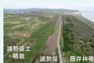
【海岸防災林を整備（白糠町）】 津波エネルギーの減衰や漂流物の捕捉等の効果が期待。
