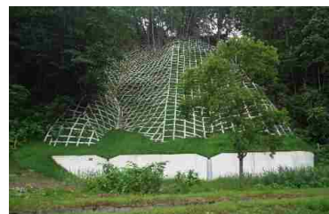
斜面の安定を図る山腹工
