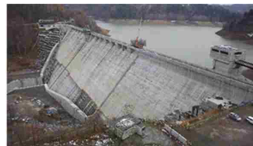
工事中の新桂沢ダム（三笠市）
