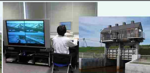
【樋門遠隔操作化（新釧路川）】 津波発生時の迅速な閉扉操作により、津波による浸水被害軽減効果が期待。
