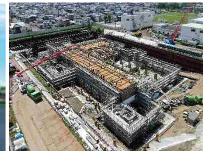
新浄水場施工状況 写真提供：釧路市
