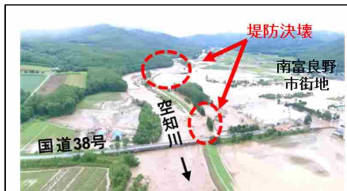
空知川の被災状況 ・堤防決壊2箇所、被災216戸、浸水面積約200ha
