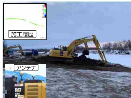
施工履歴を用いたICT施工
