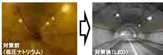
国道231号濃屋トンネル(石狩市)
