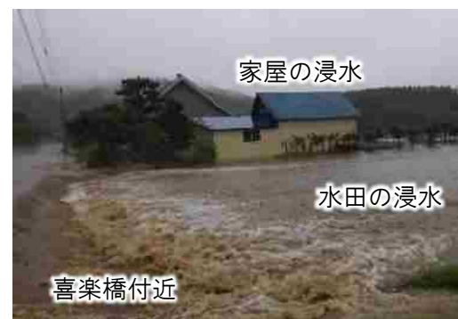
喜楽橋付近 パーパン川（旭川市）の浸水被害状況 （平成30年7月）
