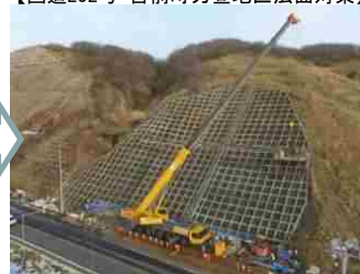
【国道232号 苫前町力屋地区法面対策】
