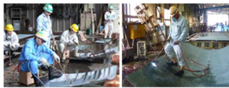
ぎょう鉄（鉄板曲げ加工）
