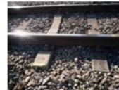
線路設備の修繕
