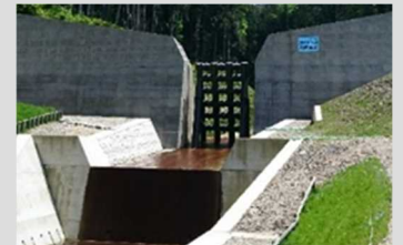
流木捕捉効果の高い砂防堰堤の設置
