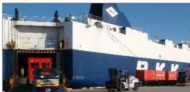
離島のフェリー航路のためのふ頭の整備
