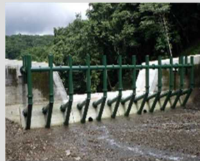
流木捕捉工の追加設置 (多機能化)
