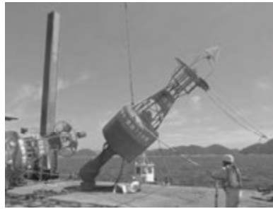
灯浮標の設置
