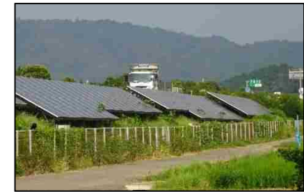
< 高速道路の盛土部を活用した発電施設の設置 >
