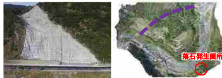
<法面法枠工> <危険箇所を回避するミニバイパス>
