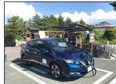
< 道の駅でのEV充電器の設置 >
