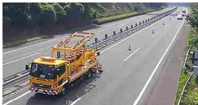
<規制機材の自動設置状況>
