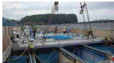
<床版取替工事の状況>
