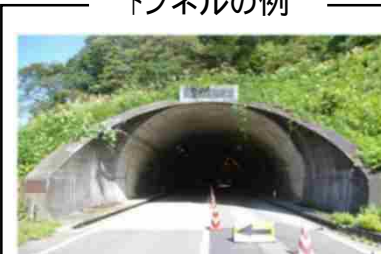
トンネルの例
