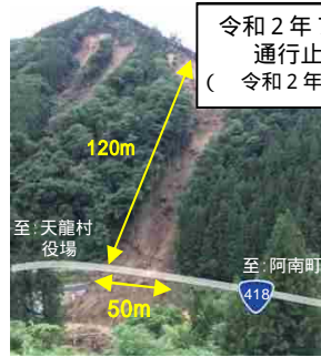
<国道418号(長野県)>
