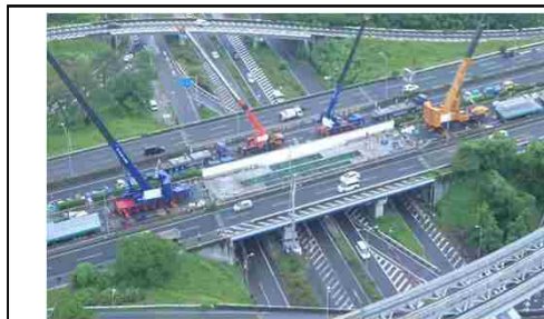
<終日通行止めによる更新事例>
