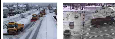
<除雪機械の増強> <チェーン着脱場>
