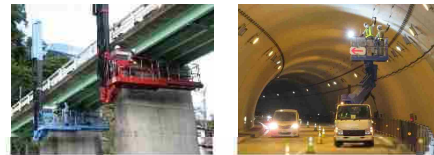
橋梁点検 (点検車) トンネル点検
