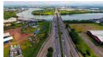
<ジャカルタ・マカッサル高速道路>
