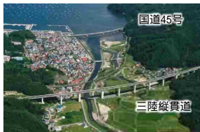
津波を考慮して高台に計画された三陸縦貫自動車道
