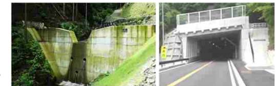
<谷止め工> <洞門工>
