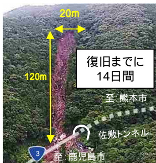
<国道3号(熊本県)>
