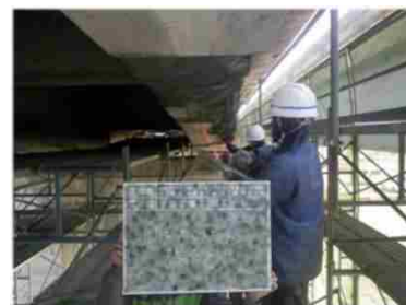
修繕の様子(断面修復)
