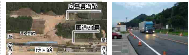
広島県道路・国道31号の被害状況
