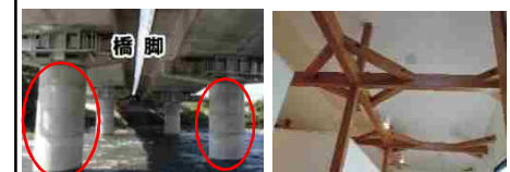
<橋梁の耐震対策> <道の駅の耐震対策>
