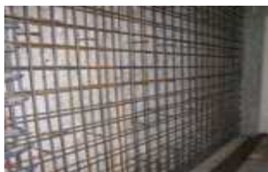
耐震壁増し打ち
