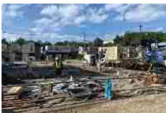
宅地の復旧工事の様子 (札幌市清田区里塚)
