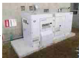
非常用発電設備の整備
