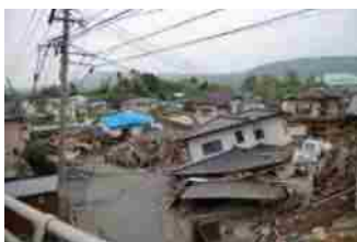
地震による被災の様子 (熊本県益城町)
