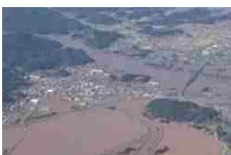
浸水被害の様子 (宮城県丸森町)
