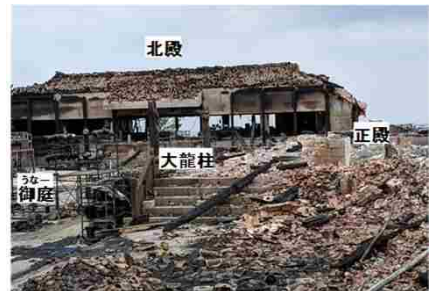
焼け残ったコンクリート構造物等を解体
