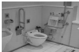
障害者対応型トイレ
