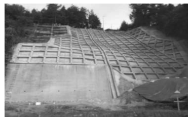
鉄道に隣接する斜面からの土砂流入防止対策
