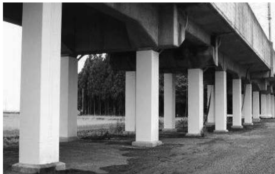
鋼板巻きによる高架橋の耐震補強
