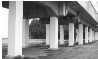
鋼板巻きによる 高架橋の耐震補強
