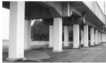
鋼板巻きによる 高架橋の耐震補強
