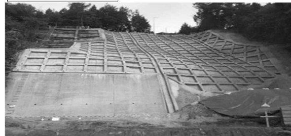
コンクリート枠による斜面の補強
