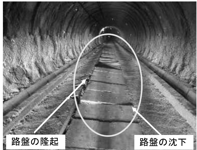
トンネル（先進導坑）の変状
