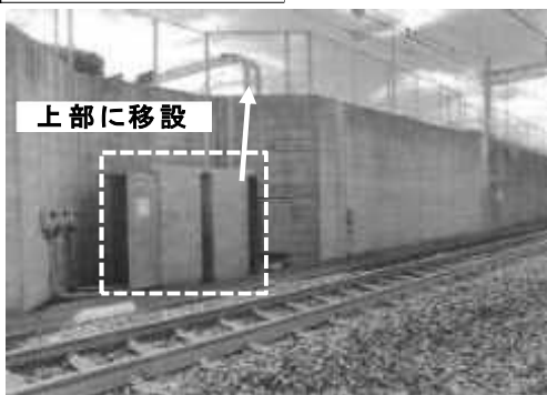
信号・通信設備の移設
