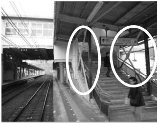
鉄骨ブレースによる 駅ホームの屋根の耐震補強
