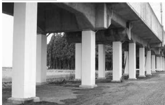
鋼板巻きによる高架橋の耐震補強
