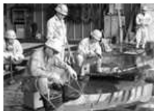
ぎょう鉄(鉄板曲げ加工)
