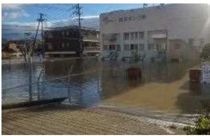
ポンプ場浸水状況
