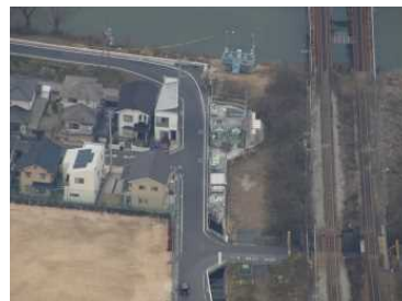
北長瀬ポンプ場 平成24年7月 稼働開始 排水能力 200m 3 /min
