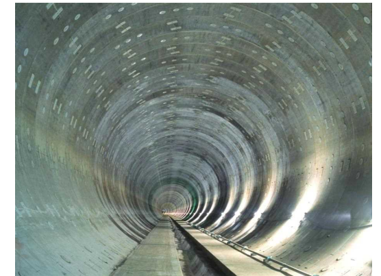
和田弥生幹線 （貯留管：直径8.5m、延長2.2km）
