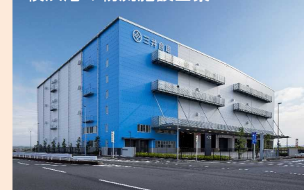
横浜港の物流施設全景
