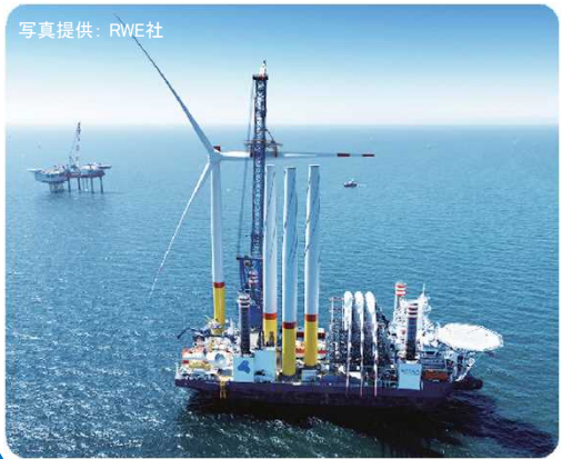
⑨ SEP船による風車設置
