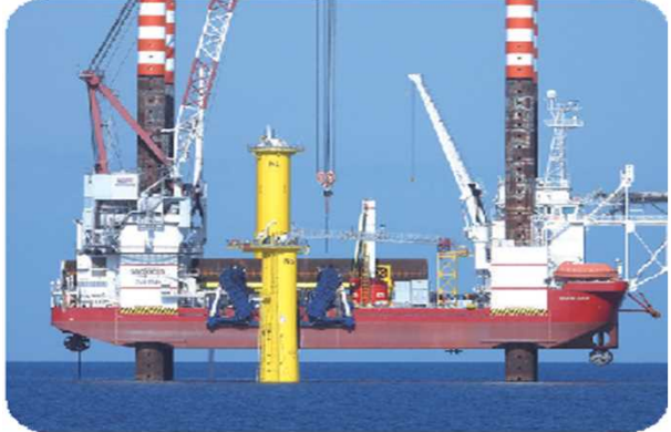
③ SEP船*1による基礎設置
