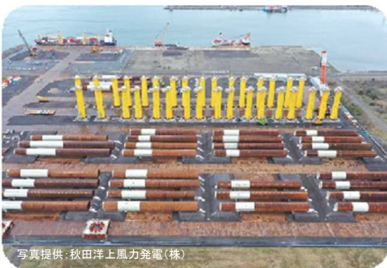
② 基礎保管・組立
