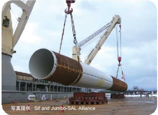
① 重量物船による基礎搬入
