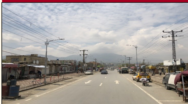
パイロット事業として整備した道路
