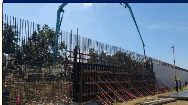
擁壁コンクリート打設施工状況
