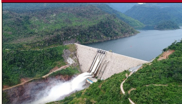
ナムニアップ1水力発電所建設工事_主ダムおよび主発電所
