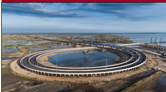
フライオーバー ループ部竣工写真
