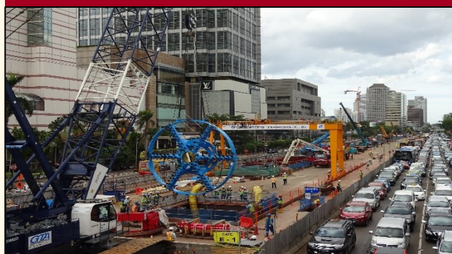
BHI駅 シールド機組立状況
