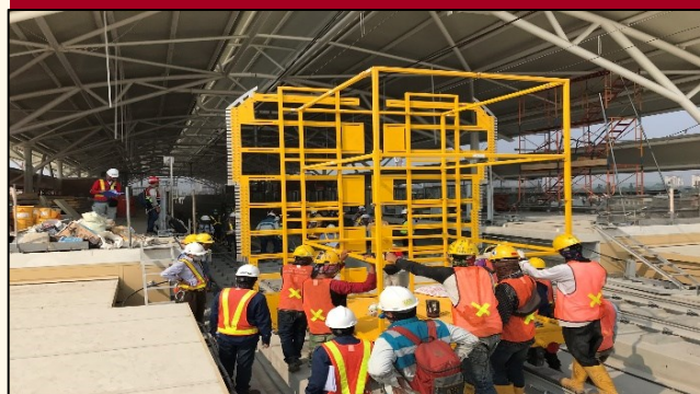
車両入線前の建築限界測定検査
