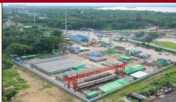
PC-I 桁製作ヤード
