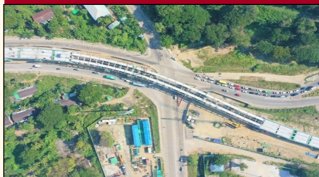
鋼箱桁架設状況
