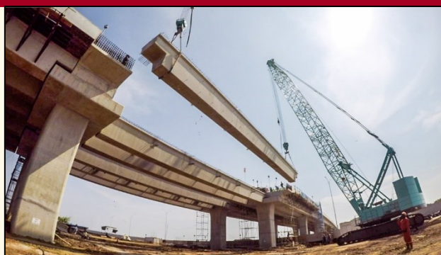
プレキャストU字桁設置状況
