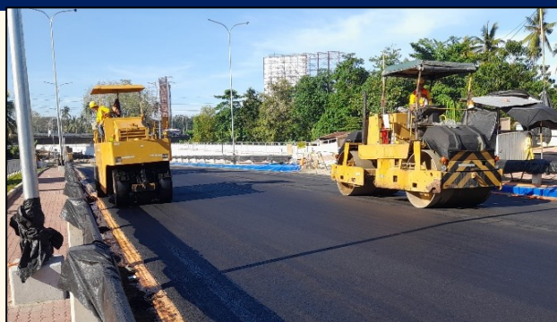
アスファルト舗装施工状況
