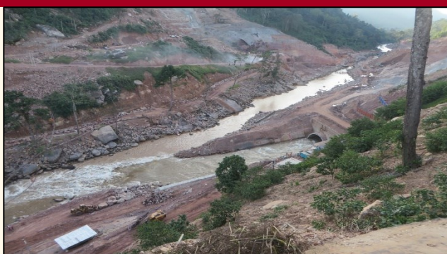
転流後状況 (Outlet側)
