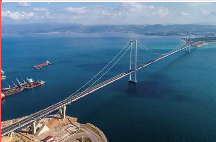
オスマン・ガーズィ橋全景
