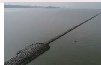
外周護岸と防波堤
