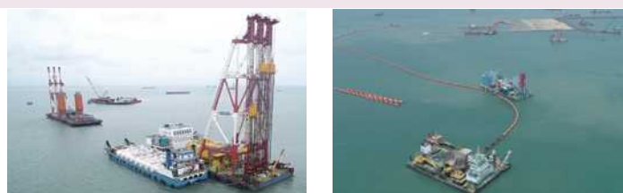
施工状況：深層混合処理工(左)、管中混合固化処理工(右)
