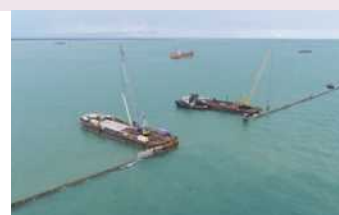
コンクリート矢板打設
