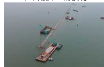
防波堤作業状況遠景
