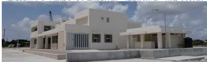
竣工時 管理荷捌き棟
