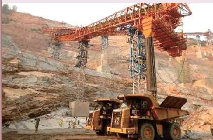
ナムニアップ1水力発電プロジェクト現場
