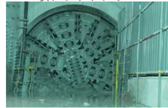
シールドトンネル貫通
