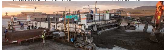
大型フィニッシャーによる滑走路舗装施工状況
