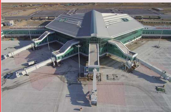
新ウランバートル空港 旅客ターミナルビル
