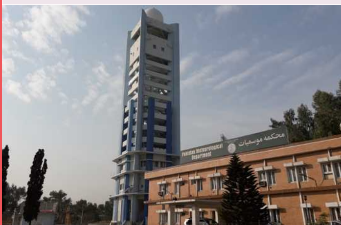
気象レーダー塔と発注者既存建物
