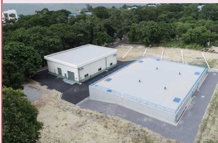
配水ポンプ場
