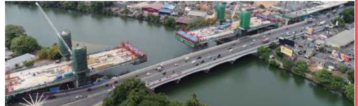
張出し施工状況
