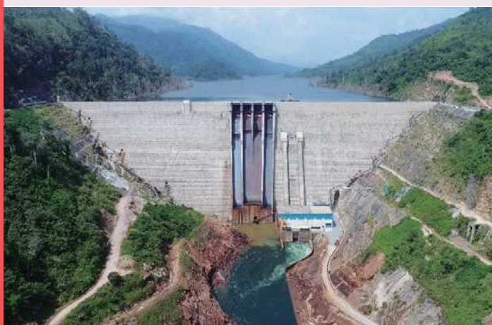
ナムニアップ1プロジェクト 完成後のRCCダム
