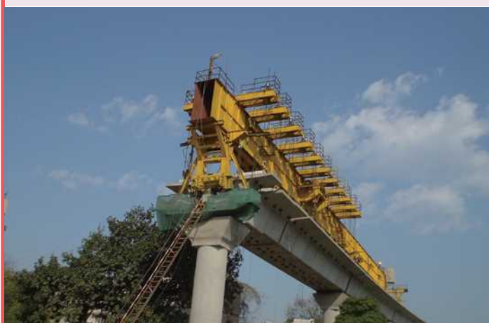
デリーメトロ 高架橋架設
