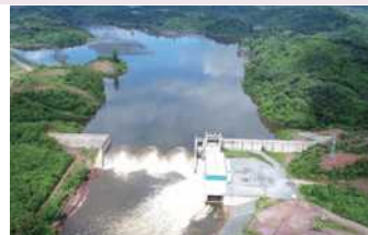
主ダムおよび主発電所
