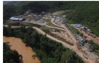
骨材生産プラント
