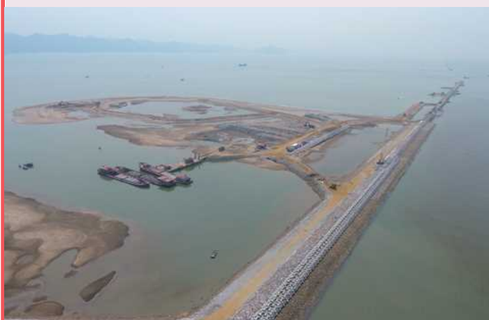
外周護岸施工①
