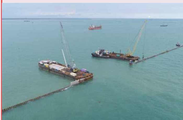
コンクリート矢板打設
