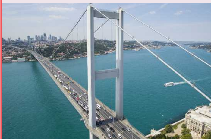
ボスポラス橋全景(1)
