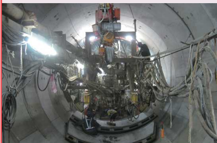
掘進作業状況(プレキャストセグメントの組立)
