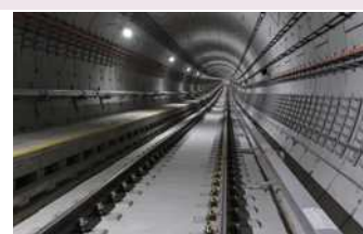
トムソンライン トンネル
