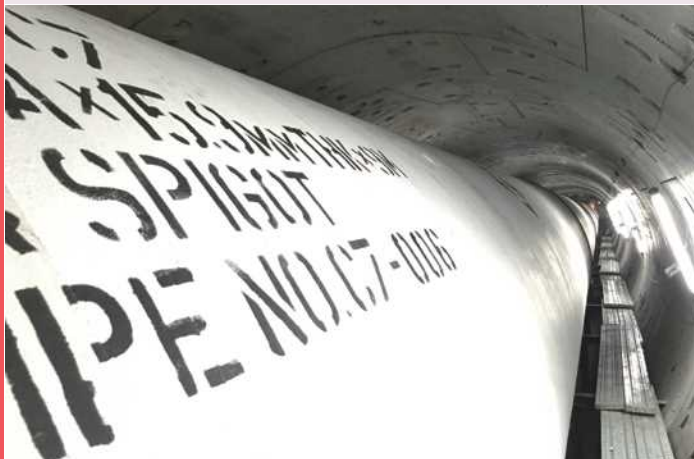
坑内での鋼管据付状況（空隙充填前）
