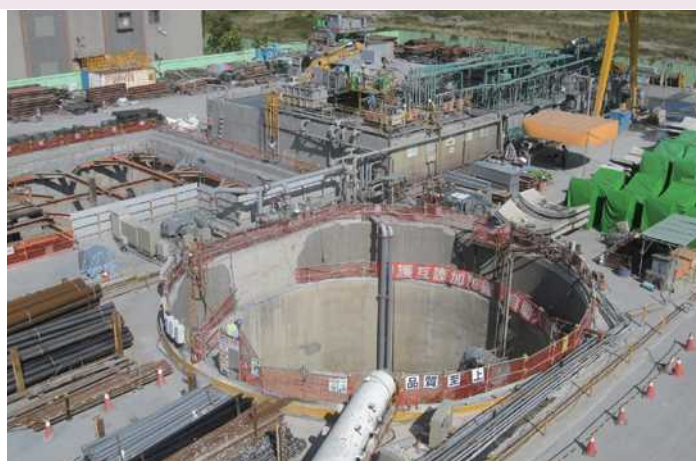
一つの発進基地(4号立坑)と地上設備及び冷却設備塔地下工事状況
