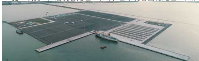
工事完成時全景
