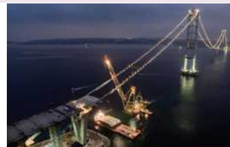
FCによる補剛桁架設状況
