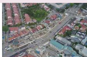
施工状況全景
