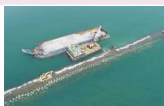
捨石投入均し
