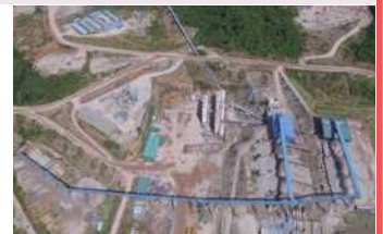
逆調整ダムおよび逆調整発電所
