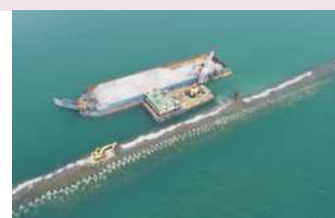
捨石投入均し
