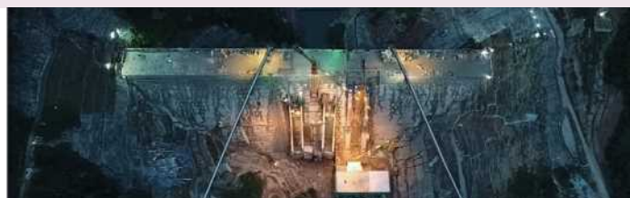
ナムニアップ1プロジェクト 建設中のRCCダム
