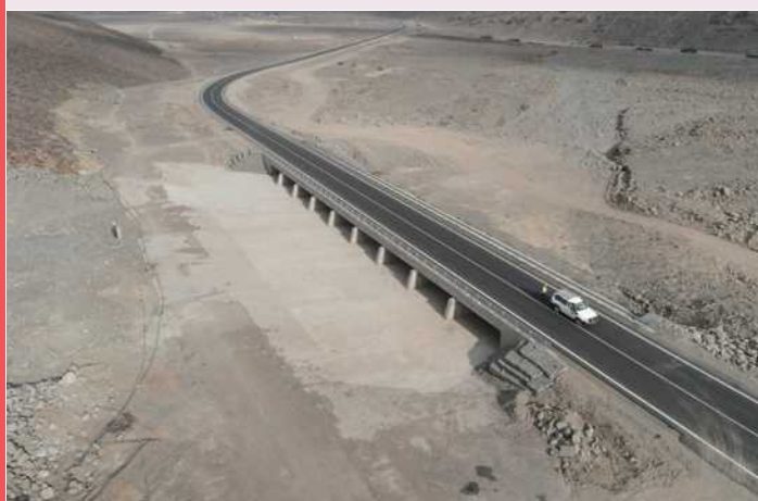
季節河川を渡河する多連ボックスカルバート
