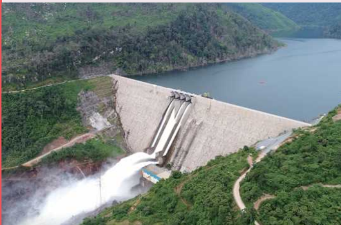
主ダムおよび主発電所
