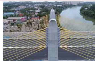
エクストラドーズド橋の斜材
