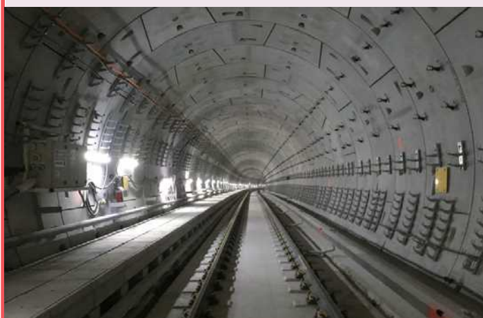
地下鉄トムソン線シールドトンネル
