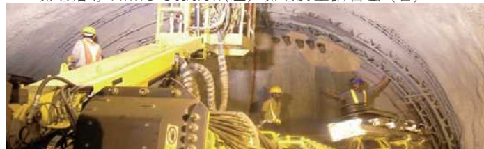
トンネル掘削現場
