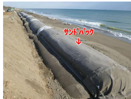
埋設護岸の整備状況写真(サンドパック充填後)
