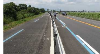
矢羽根による路面表示と案内整備、走行空間整備(拡幅)
